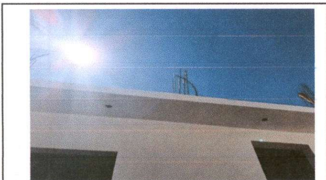
Foto 3: Repello en muro (cocina)
