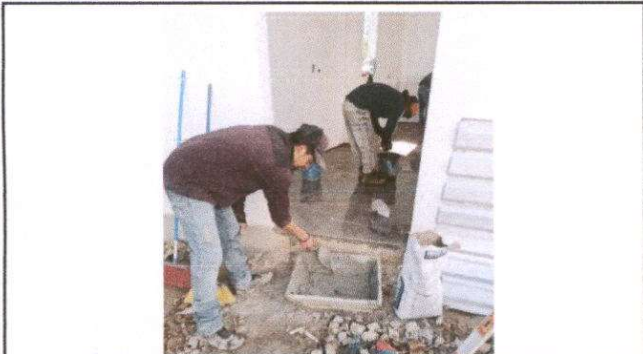
Foto 1: Sustitución de piso cerámico (cocina)
