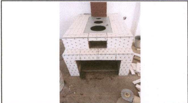
Foto 2: Sustitución de chimenea de concreto (cocina)
