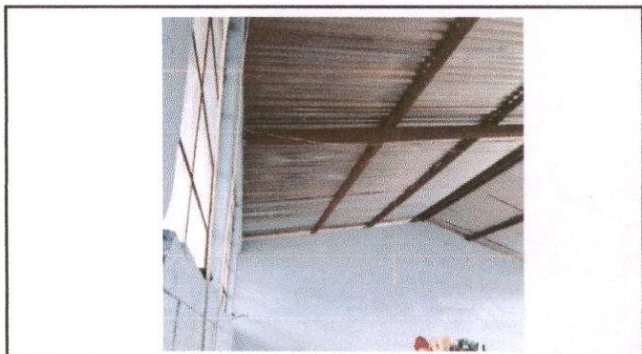
Foto 4: Pintura en muros interiores y exteriores (módulo 1)
